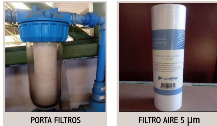
Figura 34. Porta y filtro de aire utilizado en las líneas de aireación de la planta piloto.
