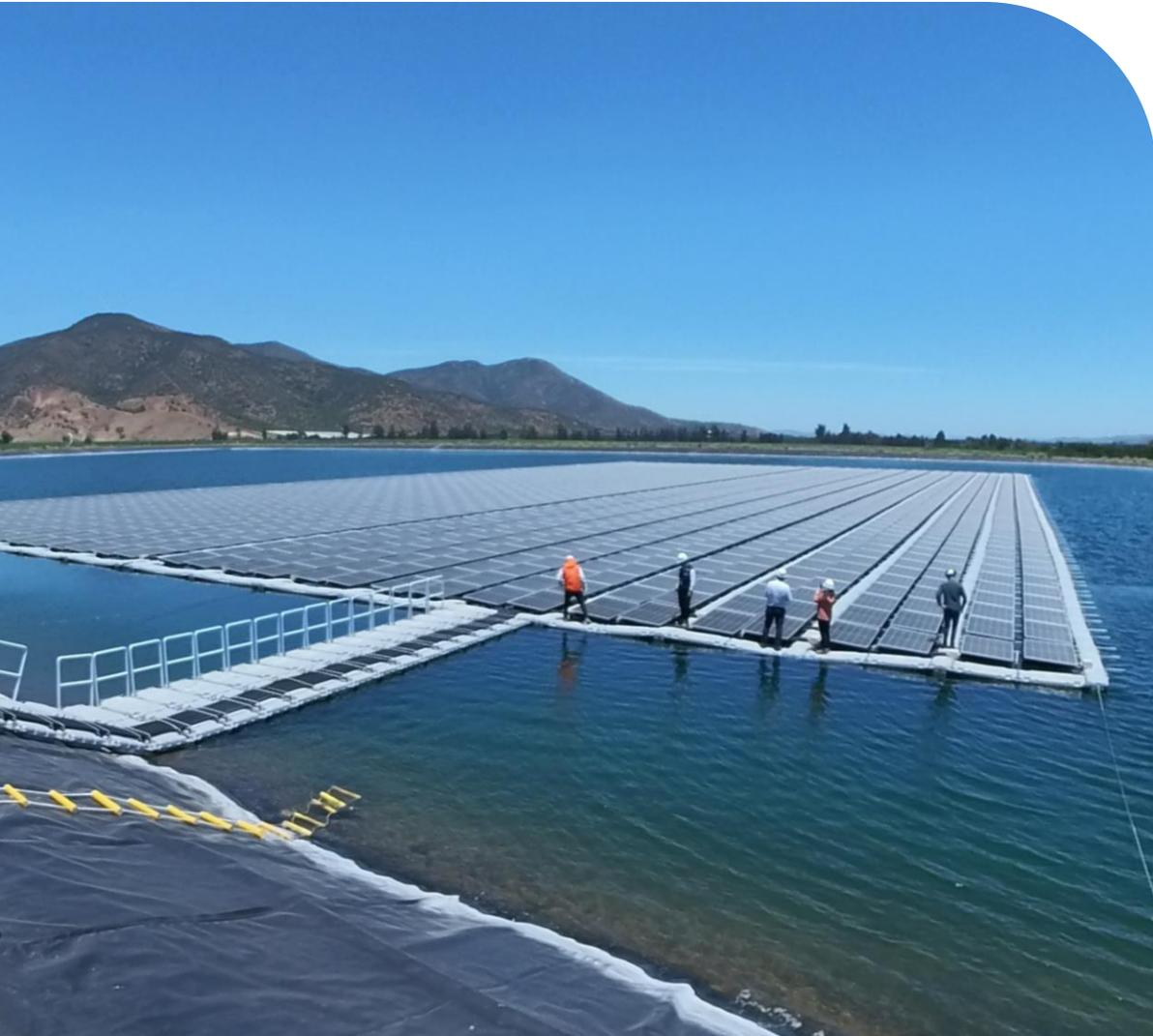
Los cambios propuestos en el instructivo técnico establecen nuevas especificaciones para las **plantas fotovoltaicas flotantes**, definiendo requisitos para la **estructura flotante**, que debe ser diseñada exclusivamente para el sistema fotovoltaico y resistir tanto las condiciones ambientales como el **tránsito del personal**. Se detallan los materiales recomendados, **los métodos de anclaje**, y las normas que deben cumplir los módulos en ambientes salinos.
