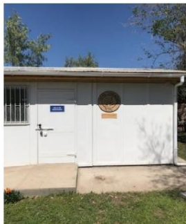
Zona de envasado (exterior)
