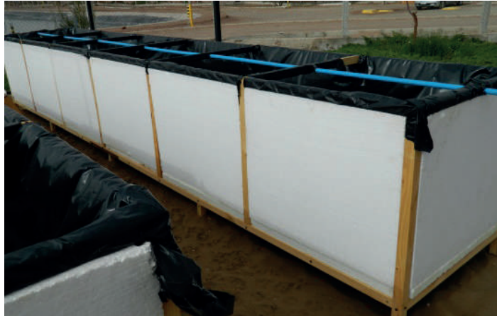
Figura 19. Vista exterior estructura de una unidad aeropónica construida en madera. Alto Hospicio
