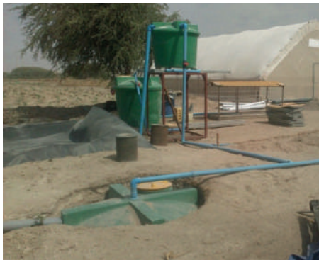
Figura 10. Filtro mixto para remoción de Boro. Pozo Almonte
