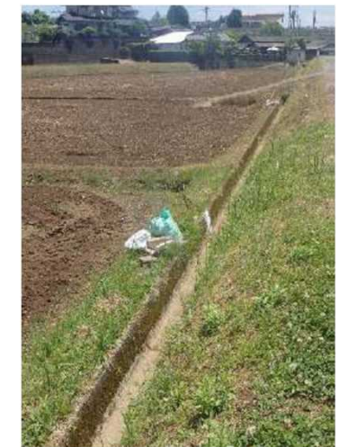
Reparación de canales de riego
