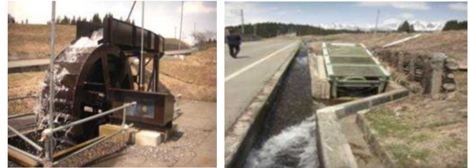
Vista exterior de la instalación
