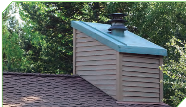
Figura 15. Chimenea despejada de vegetación.
