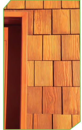
Figura 20. Revestimiento con tejas de fibrocemento.
