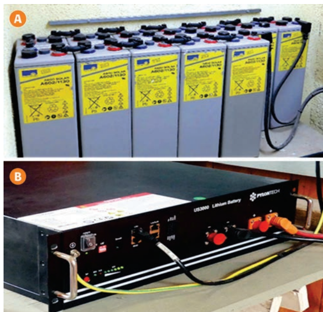
Figura 4a. Banco de baterías solares de plomo-ácido. 4b. Banco de baterías de litio.
