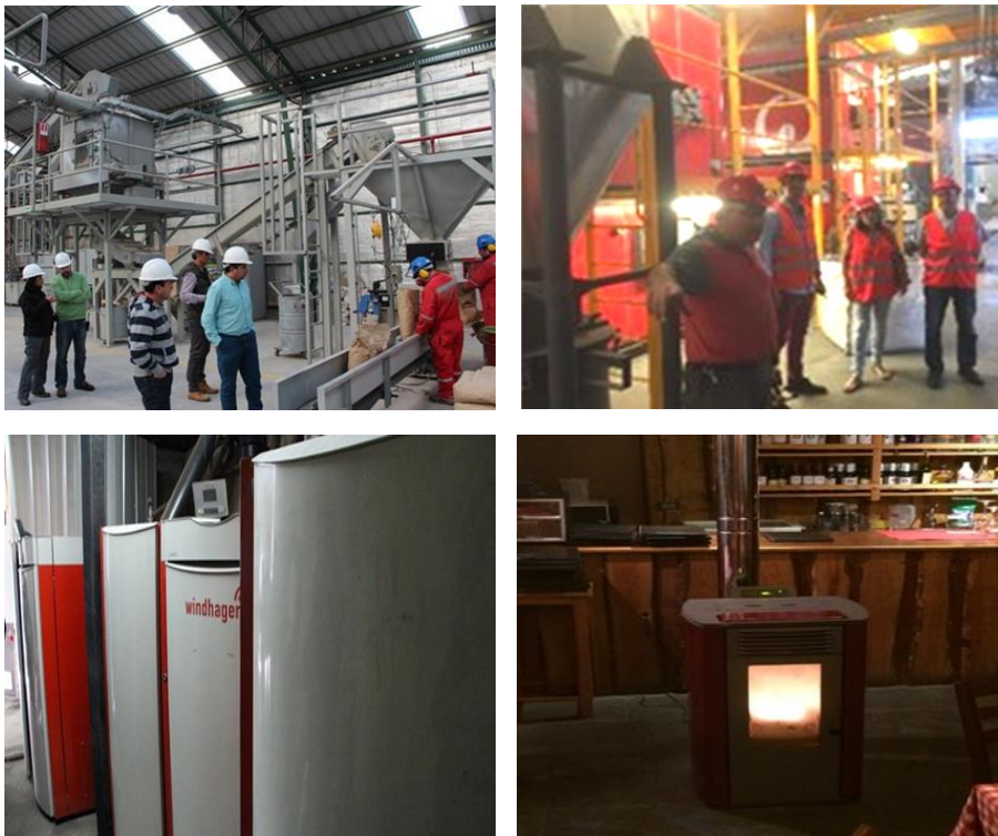
Superior: Planta productora de Pellet (izq) Plantas de generación en base a pellet (der) Inferior: Caldera industrial (izq) Estufa de uso domiciliario (der)
